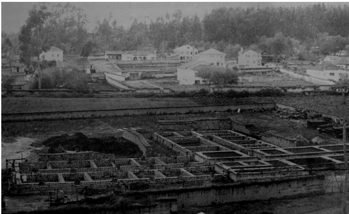
1954. Cimientos del hospital
