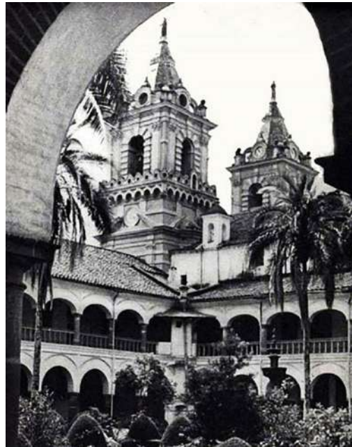
Convento de San Francisco luego del terremoto
