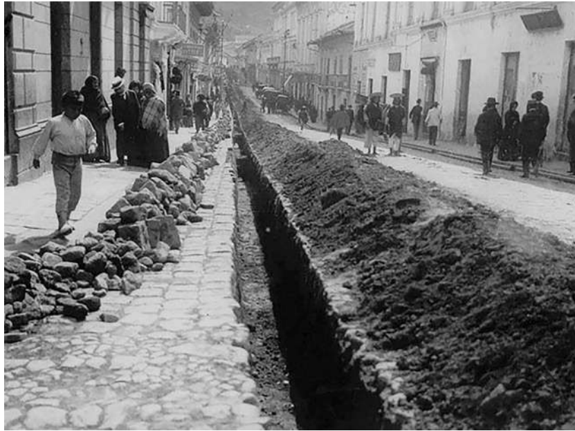
Obras de canalización en Quito a comienzos del siglo XX
