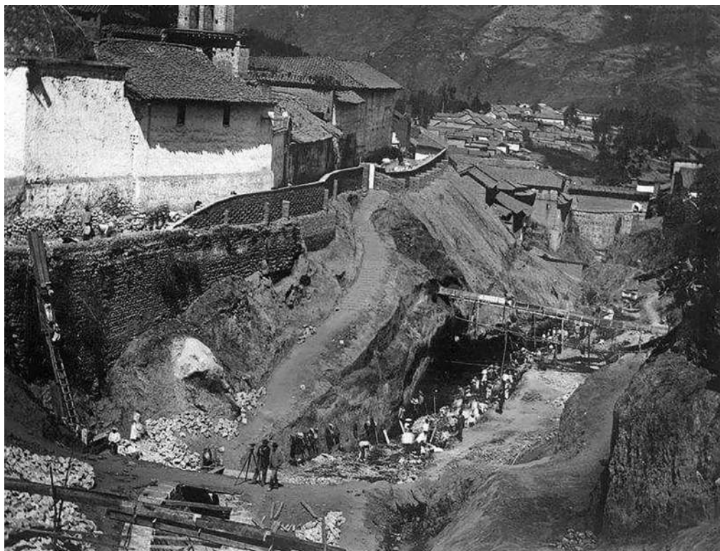
Trabajos de relleno en la quebrada de Jerusalén antes de 1922
