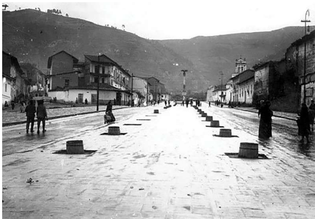
La avenida 24 de Mayo luego del relleno de la quebrada
