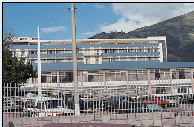
La fachada del Hospital con nueva pintura
